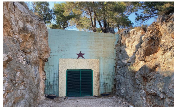
Подземни објекат на острву Ластово
